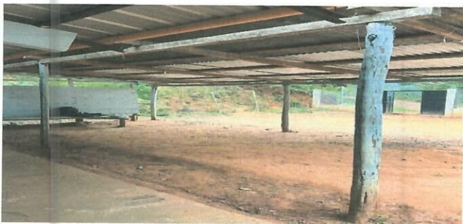
MEJORAMIENTO DEL TECHO DE GALERA, PARA TENER UN ESPACIO DISPONIBLE PARA ACTIVIDADES ESCOLARES PARA LOS NIÑOS.
